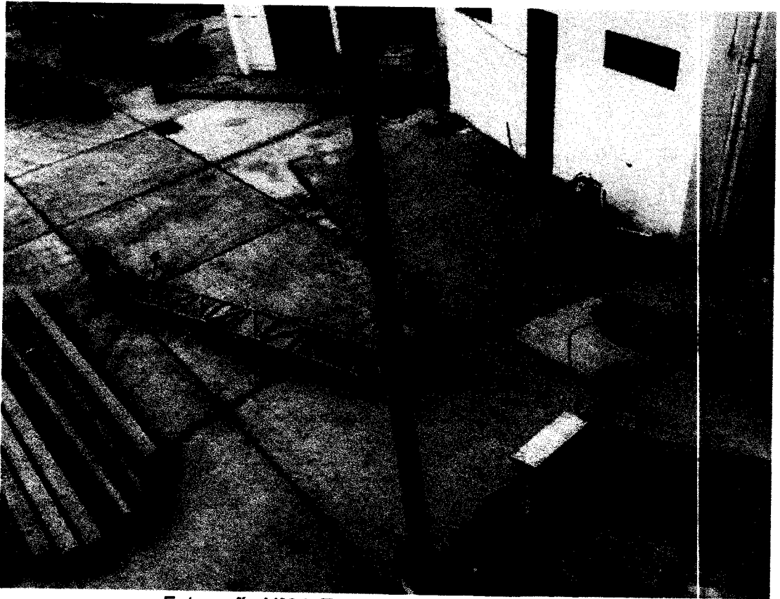
Fotografía N°04: Traslado de tijerales metálicos.
