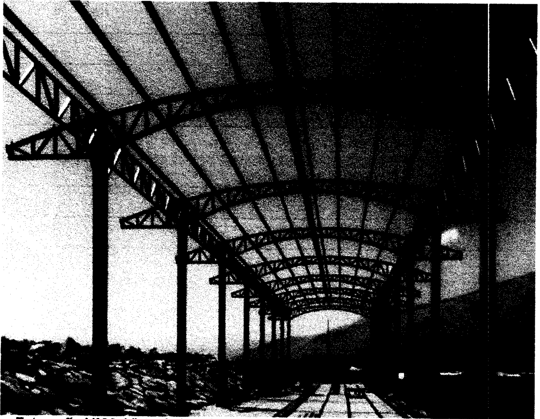
Fotografía N°28: Vista de instalación de correas metálicas en estructura tipo IV.
